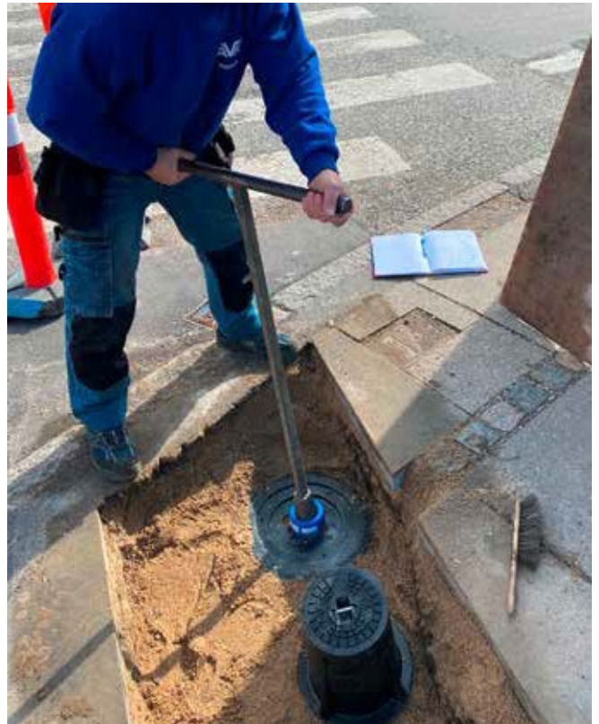
Zasuwa w ziemi z pozycjonerem VIDI, który wykrywa, kiedy zasuwą jest używana.
