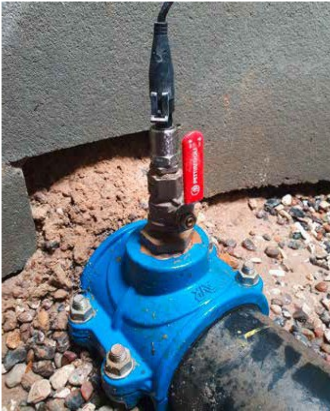
Ze względu na bezprzewodowy charakter IoT, czujniki ciśnienia mogą być instalowane w dowolnym punkcie sieci dystrybucyjnej.
