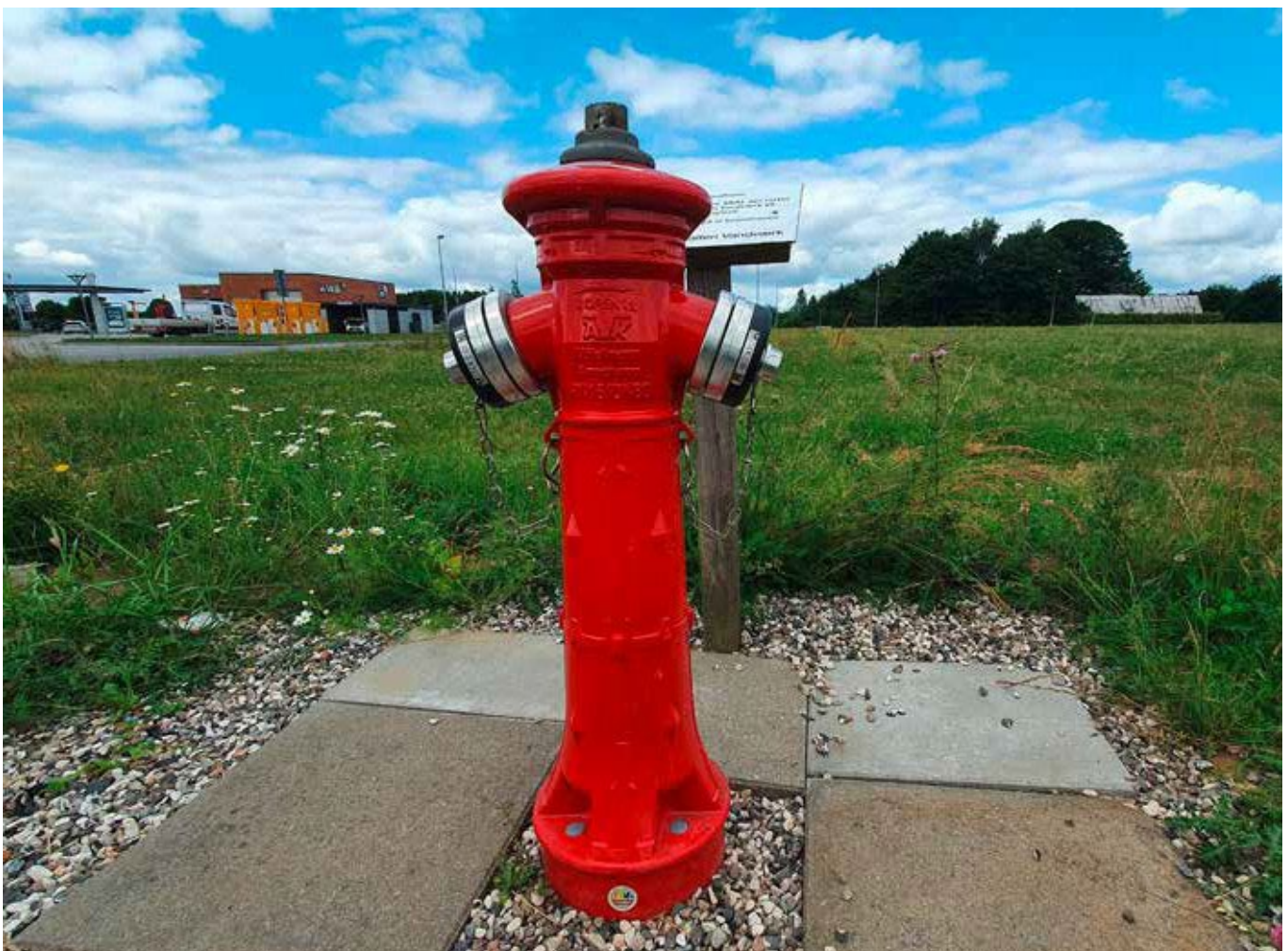
Hydrant z zainstalowanymi VIDI Pokrywy Nasad. Korzystanie z hydrantu wpływa na ciśnienie w danym obszarze. Ważne, aby przedsiębiorstwo wodociągowe wiedziało, czy spadek ciśnienia spowodowany jest użyciem hydrantu czy awarią rurociągu.
